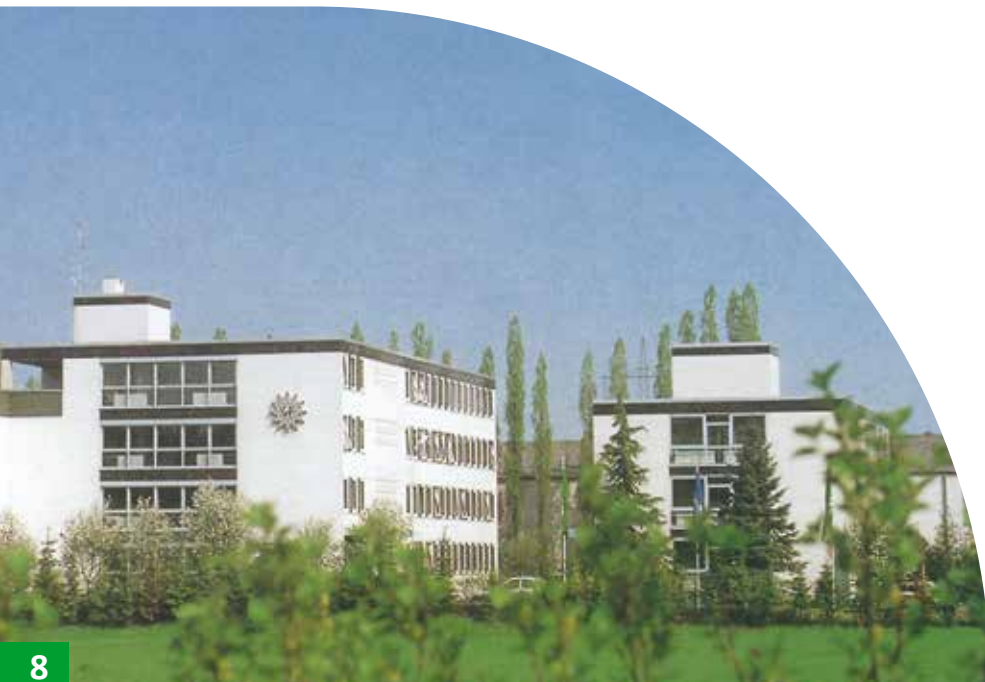
Das neue Gewerkschaftshaus in Hilden
